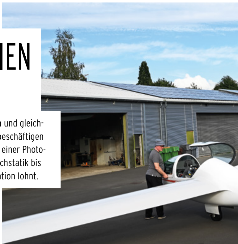
Der LSV Wipperfürth produziert rund 70 Prozent seines Stroms selbst, dank zweier PV-Anlagen auf dem Dach seines Hangars.
